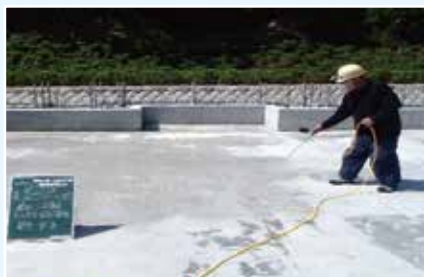
■ 平成24年三島スカイウォーク屋上床面 新築防水、工事中に漏水、カリウム浸透性防水材で防水、現在漏水なし。
