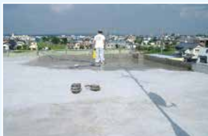
■ 平成17年 シートが浮いていて2部屋から漏水 既存シート撤去後、接着剤を除去してカリウム浸透性防水材を塗布、現在も再漏水なし。
