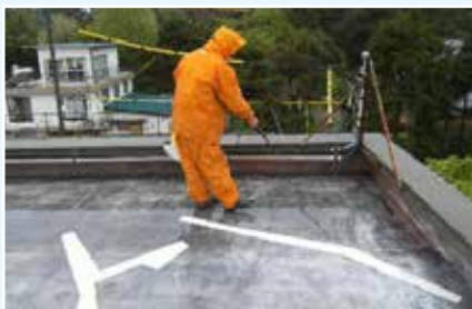
■ 平成29年 マンション屋上床面 台風被害のため、緊急で雨の中施工、止水成功、現在も再漏水なし。
