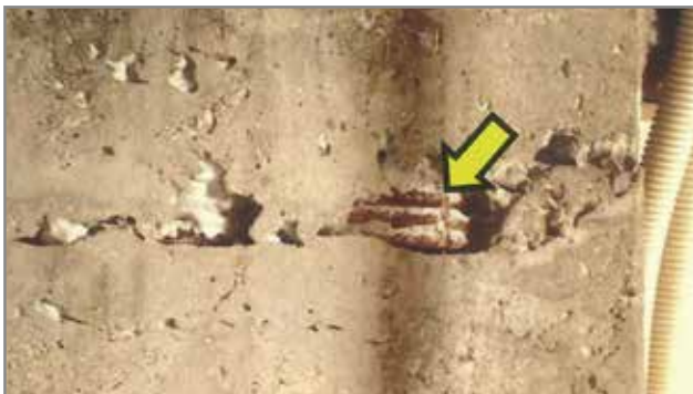
■ 床コンクリート端末の金属との境界
