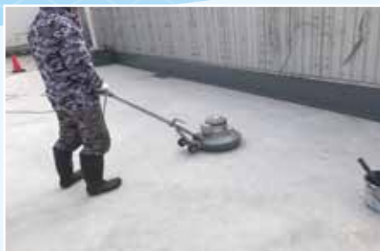
■ 令和3年4月 スーパーマーケット・コンクリート床面 3箇所から漏水、既存FRP防水層除去研磨しカリウム浸透性防水材で防水、現在再漏水なし。
