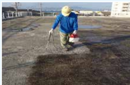
■ 平成24年三島スカイウォーク屋上床面 新築防水、工事中に漏水、カリウム浸透性防水材で防水、現在漏水なし。
