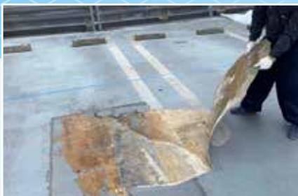
■ 令和3年4月 スーパーマーケット・コンクリート床面 3箇所から漏水、既存FRP防水層除去研磨しカリウム浸透性防水材で防水、現在再漏水なし。
