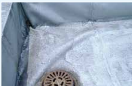
■ 平成17年 シートが浮いていて2部屋から漏水 既存シート撤去後、接着剤を除去してカリウム浸透性防水材を塗布、現在も再漏水なし。
