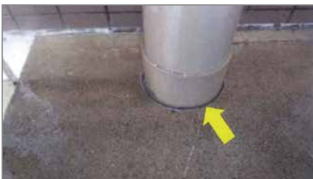
■ 入り隅シール打ち 変性シリコン
