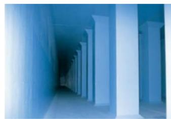
上水道貯水槽内面保護塗料「ガードブルーF」
